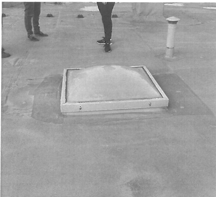
Fot.18 istniejący świetlik zamontowany zbyt nisko
