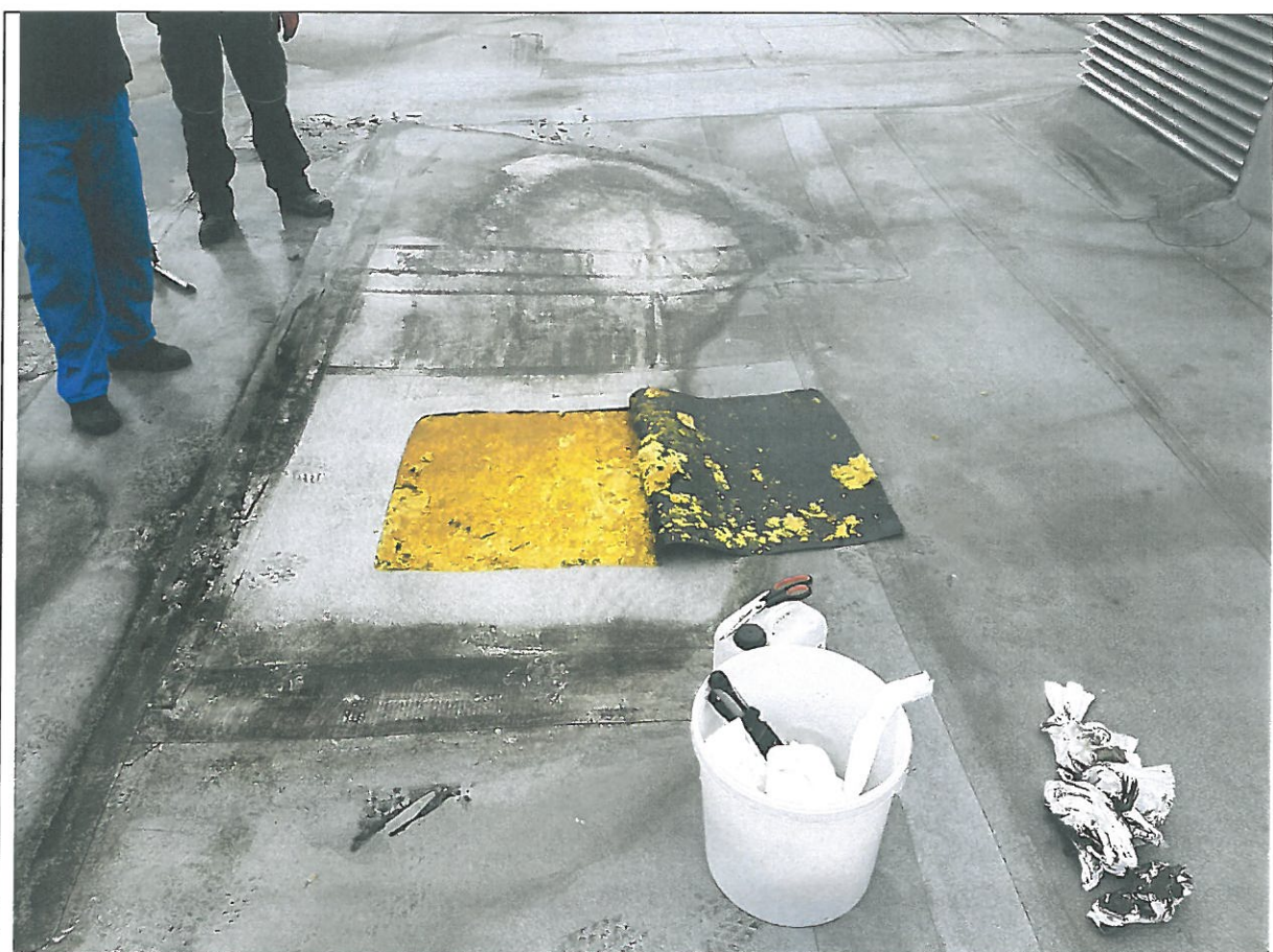
fot.9 Odkrywka wykonana w części centralnej stropodachu budynku wyższego.
