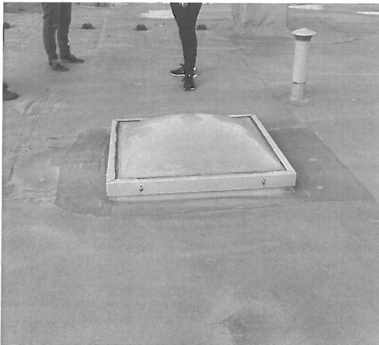
Fot.18 istniejący świetlik zamontowany zbyt nisko
