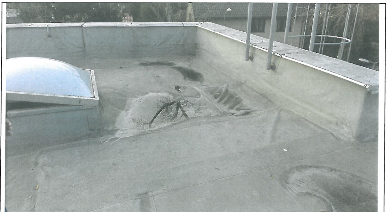
fot.4 Fragment stropodachu o układzie warstw nr 2 (część wyższa zachodnia)
