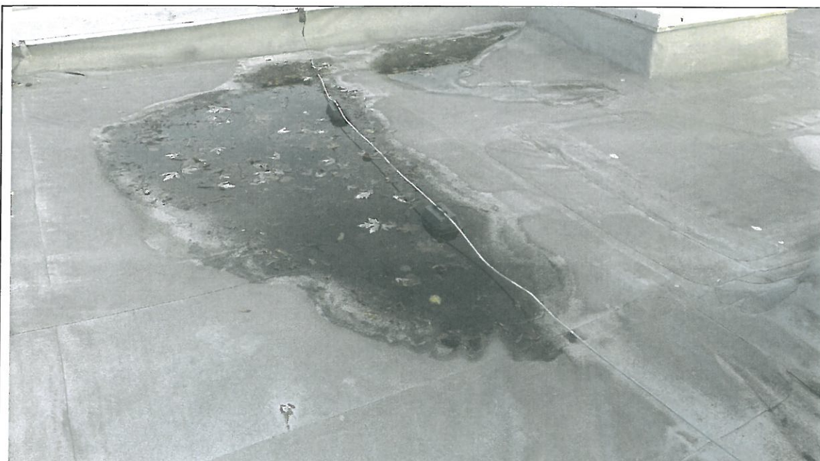
fot.8 Magazynowanie wody na powierzchni dachu
