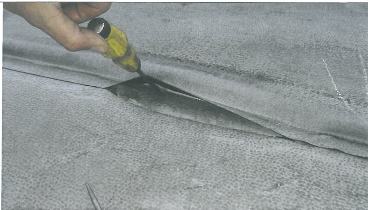
fot.22 Brak odpowiednich połączeń hydroizolacji
