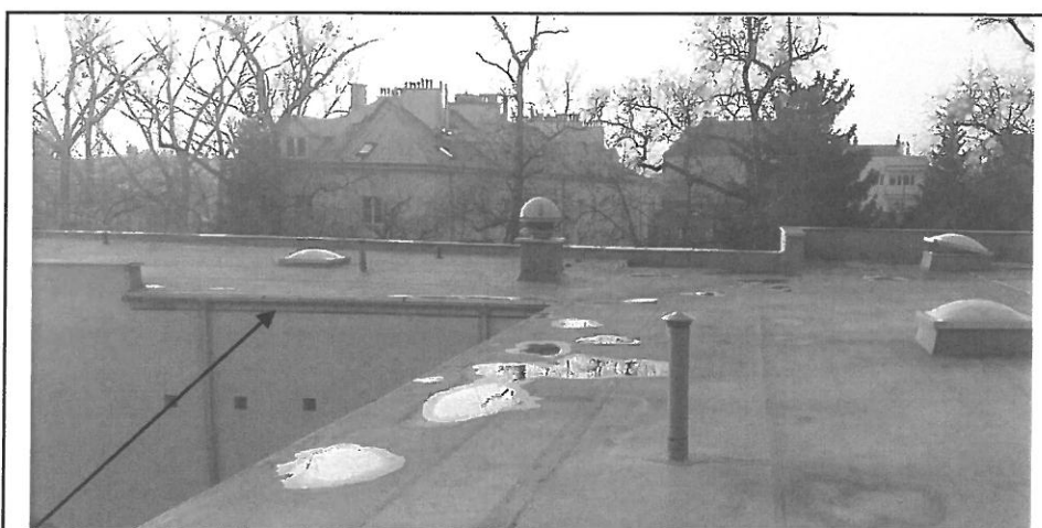
Fot.17 istniejące świetliki, wyłazy i klapy dymowe
