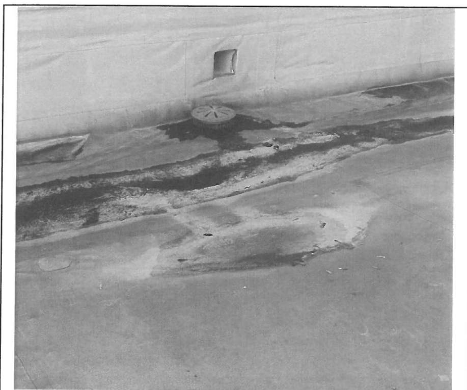
Fot.15 istniejący wpust dachowy – zapadliska i deformacja spadków uniemożliwiają odprowadzenie wód opadowych
