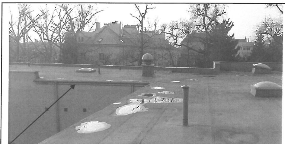
Fot.17 istniejące świetliki, wyłazy i klapy dymowe
