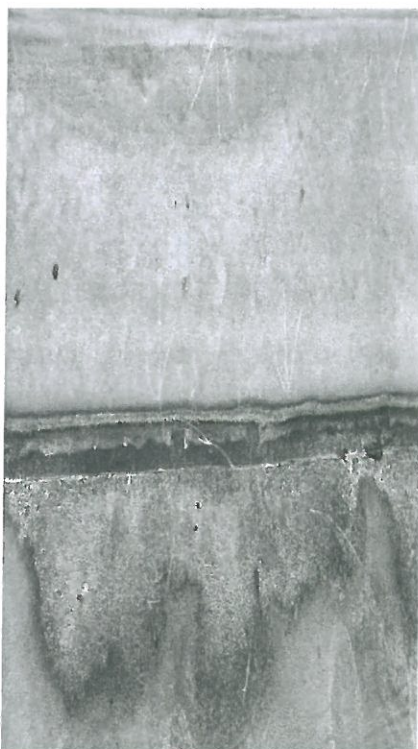
Fot.23 Uszkodzenia membrany i przecieki wynikające z nieprawidłowego wykonania
