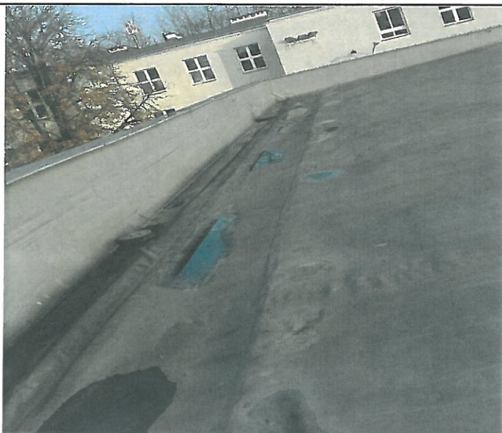
Fot.14 przedstawiająca istniejące wpusty dachowe na dachu z blachy trapezowej
