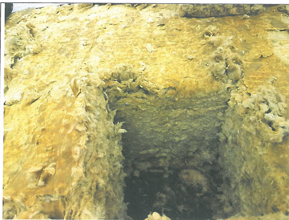
fot.12 Nacięcia wełny wykonane w celu ukazania całej grubości termoizolacji
