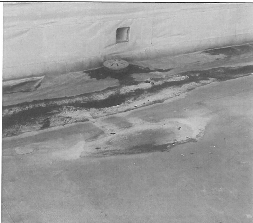
Fot.15 istniejący wpust dachowy – zapadliska i deformacja spadków uniemożliwiają odprowadzenie wód opadowych
