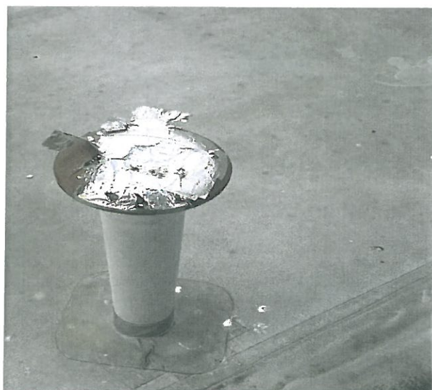
Fot.25 Wywiewki kanalizacyjne wymagające wymiany
